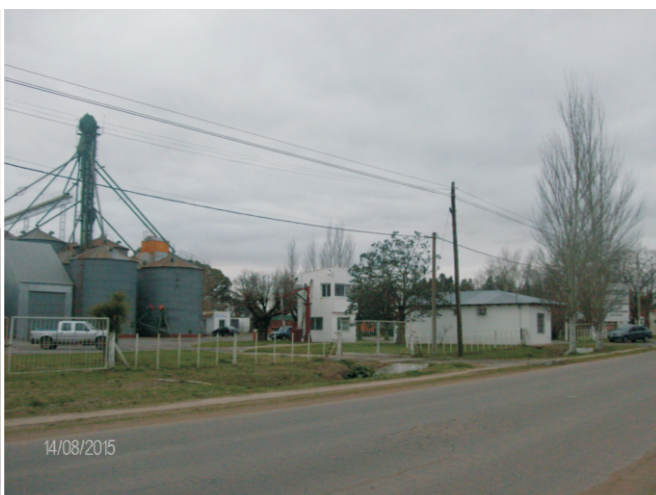
Las instalaciones ubicadas en la Avda. Seguí, constan de una planta de acopio con capacidad para 11.000 toneladas, tiene celda, plataforma de descarga y caladora hidráulicas, secadora nueva y galpón, todo sobre en un predio de 2 hectáreas.
